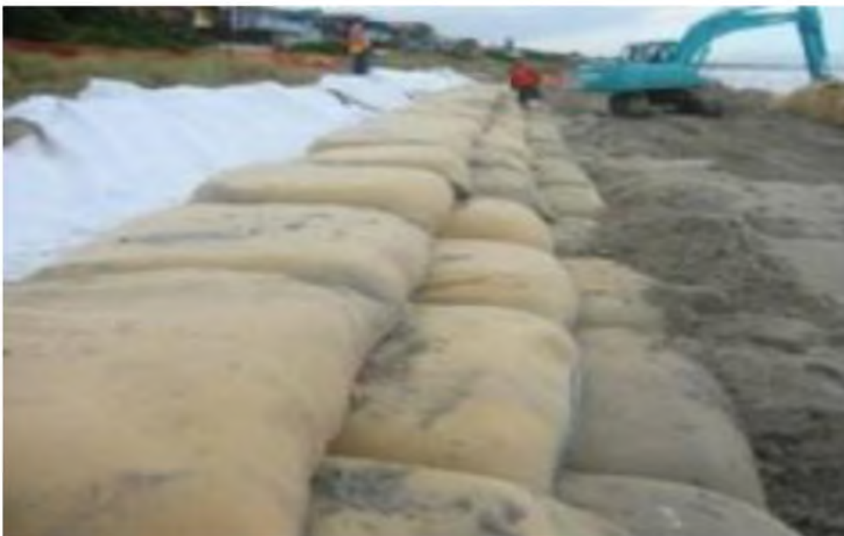
Берегоукрепительные работы на Цимлянском водохранилище
